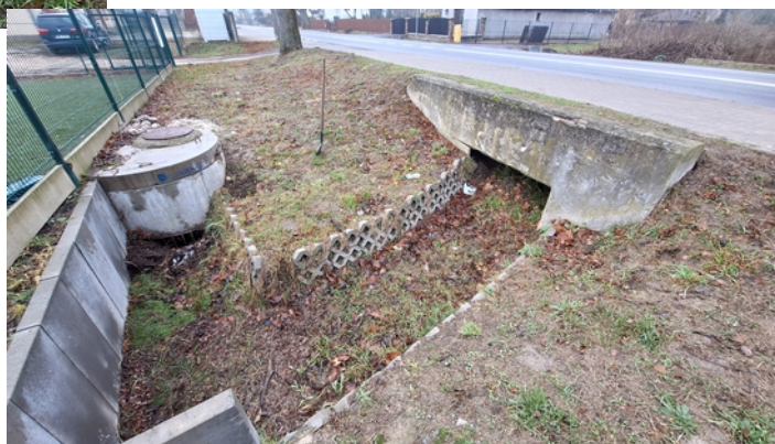
Wylot z przepustu
